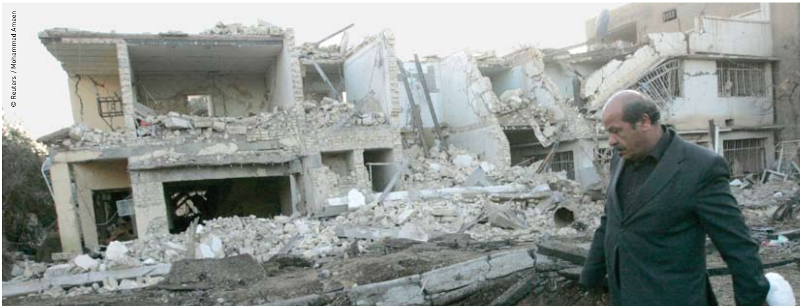
Total zerstörte Häuser nach einem Bombenanschlag – ein häufiges Bild in Bagdad.
