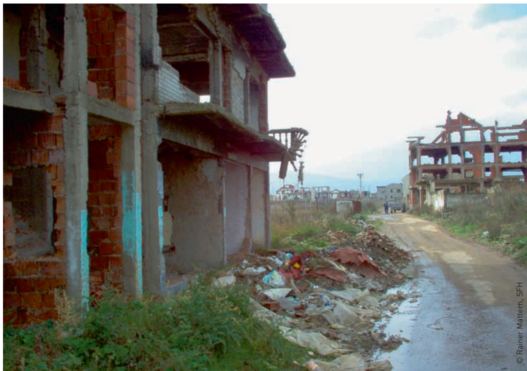
Nur noch Ruinen: Zerstörte Wohnhäuser von Roma-Familien in der Region Süd-Mitrovica.
