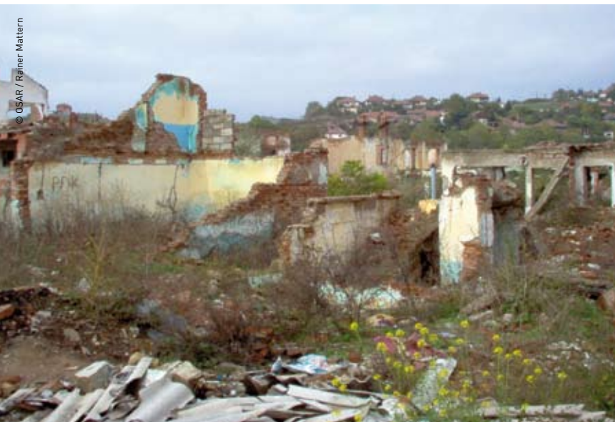
La cité Roma-Mahalla complètement détruite (image d'archive de 2004).
